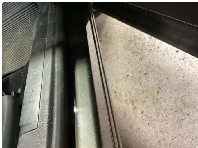
1.2 Noe riper i innsteg.
