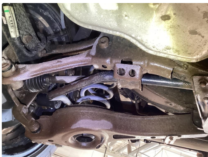
1.2 Noe overflaterust i travers bak. Ingenting alvorlig.
