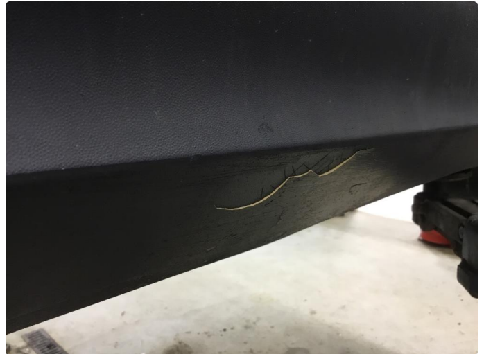
1.2 Ufagmessig utført arbeid
