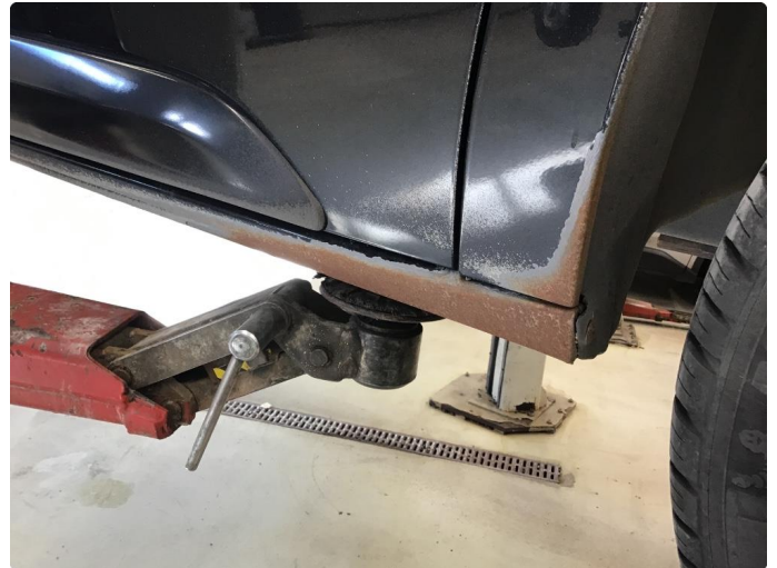
1.1 Steinsprut med rust
