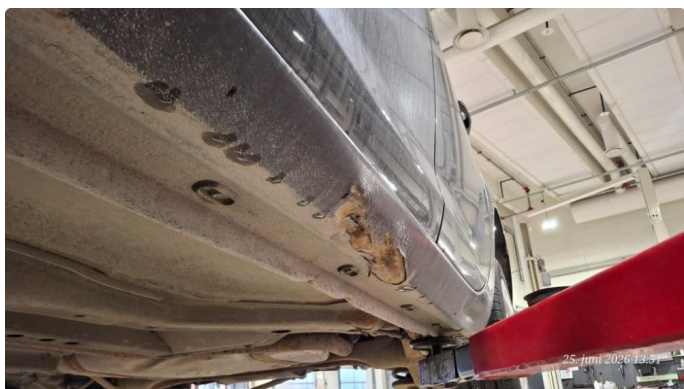
1.2 Generelt mye rust
