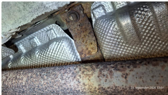
5.2 Dårlig feste drivstofftank
