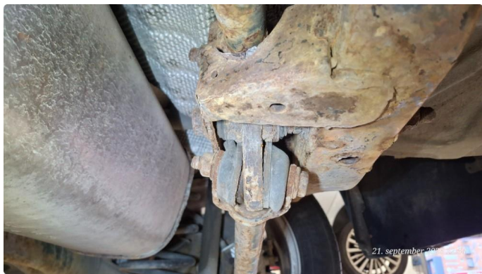
3.3 Generelt mye rust
