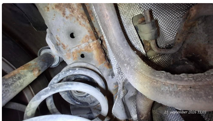
3.3 Generelt mye rust
