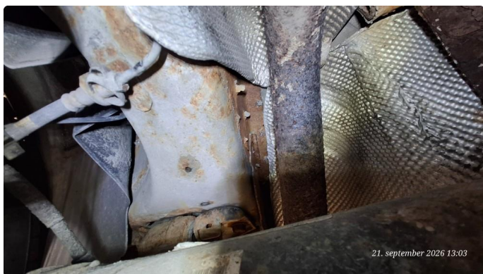
3.3 Generelt mye rust
