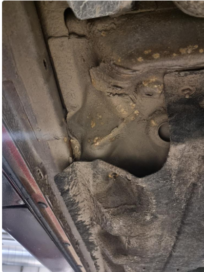
1.1 Noen merker etter jekk
