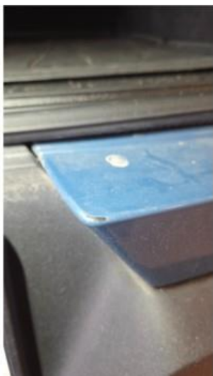
1.1 Liten lakkskade i innlastningssone
