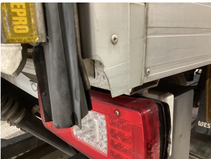
1.3 Sprukket plast nedre hjørner på skap
