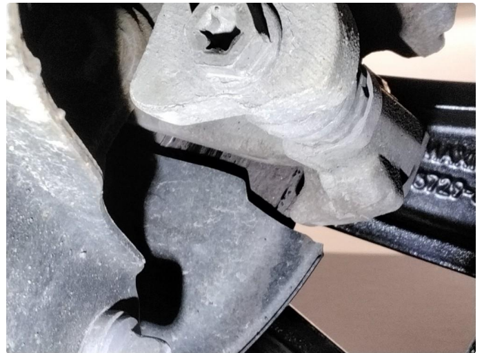
2.1 Mer enn 25% rust.
