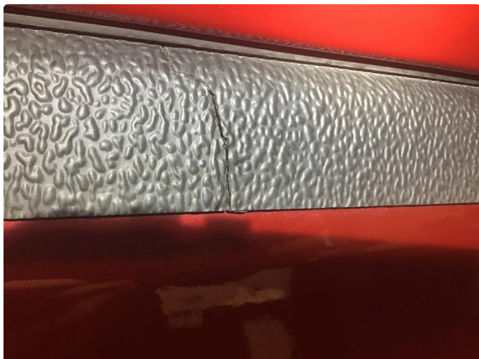
1.2 Liten sprekk i planlegg venstre side
