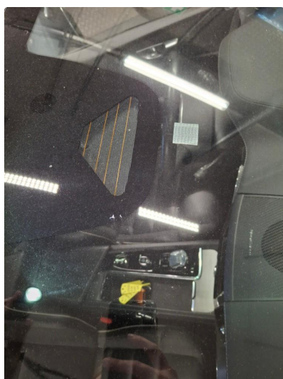
1.4 Steinsprut utenfor synsfelt
