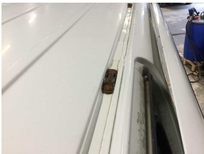
1.1 Flekkvis noe korrosjon/rust
