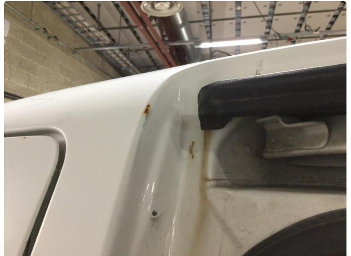
1.1 Flekkvis noe korrosjon/rust
