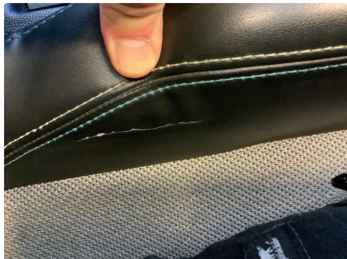
2.1 Liten sprekk på setetrekk venstre fram på sidevange
