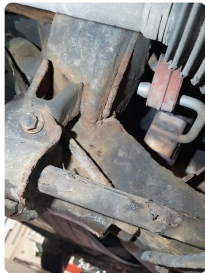
2.2 Rust Er en del rust på understell. Ikke noe farlig rust foreløpig.
