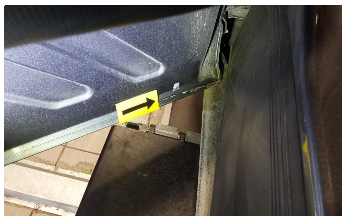
1.5 Rust i fals
