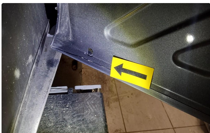
1.5 Rust i fals
