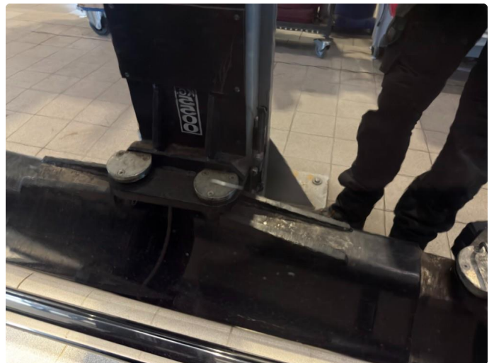
1.1 Noen steinsprut og slitasjemerker
