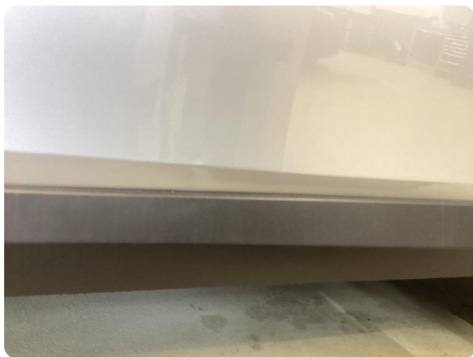
1.6 Bulk Framme høyre dør
