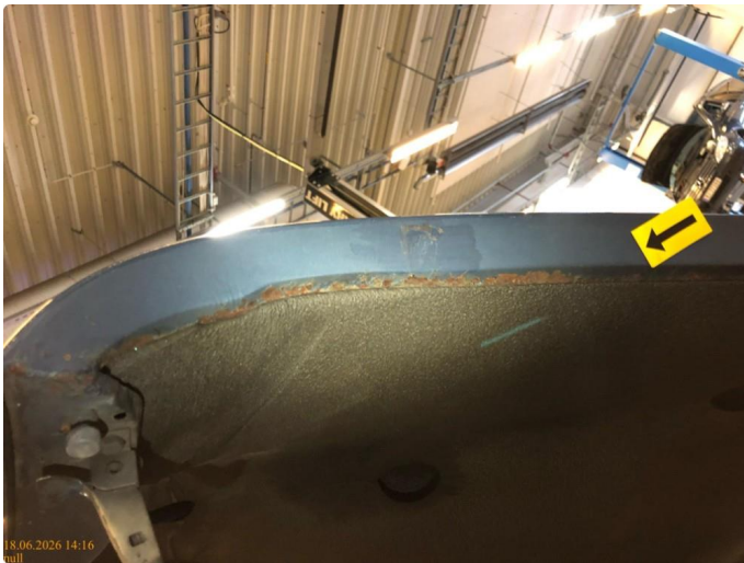
1.3 Løs matte under panser, se vedlagt bilde.
