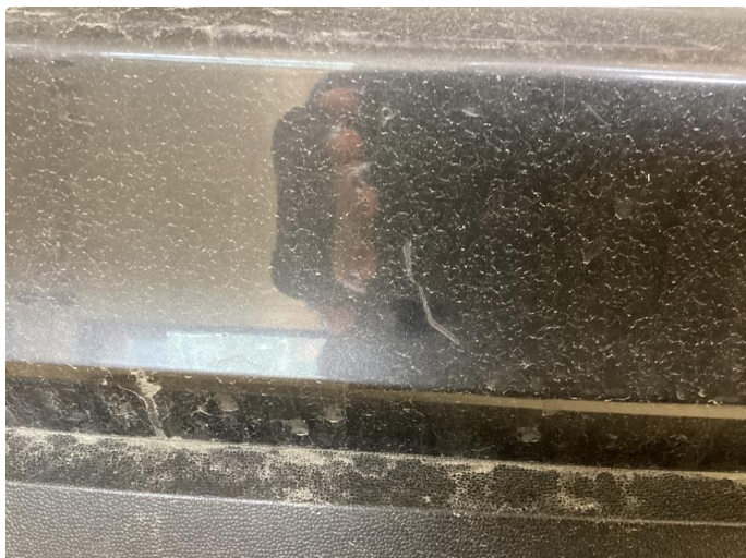
1.2 Ripe(r) ned til grunning
