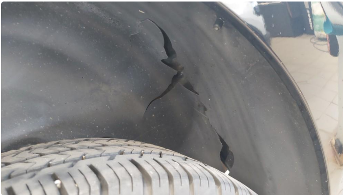
1.1 Hjul bue deksel skadet
