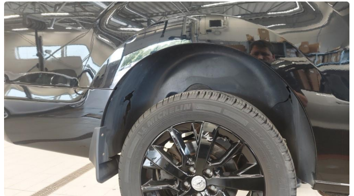
1.1 Hjul bue deksel skadet
