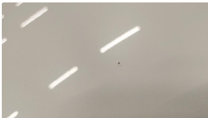
1.3 Steinsprut med rust
