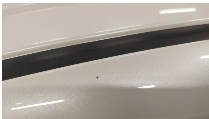
1.3 Steinsprut med rust
