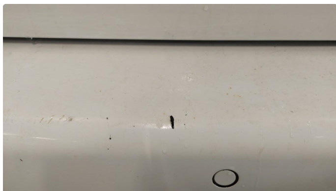
1.8 Ripe(r) ned til grunning
