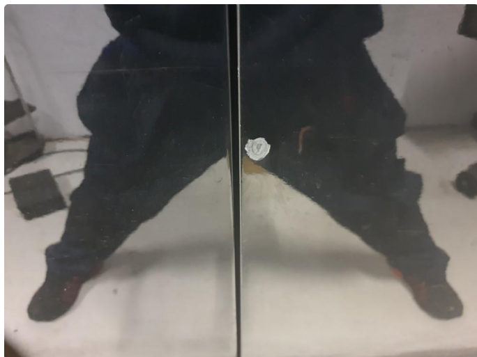
1.2 Lakk flasser på h/dør ( utbedret med flikk lakk )
