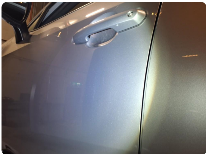
2.1 Generelt mye riper og småbulker Og steinsprut
