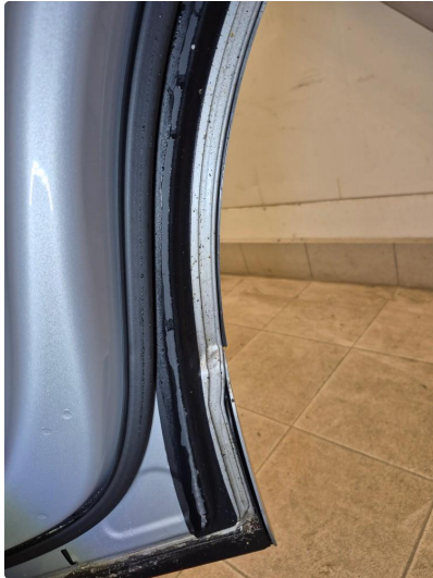
1.1 Steinsprut med rust
