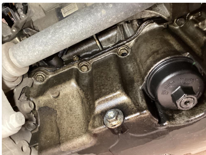
2.1 Oljelekkasje fra motor
