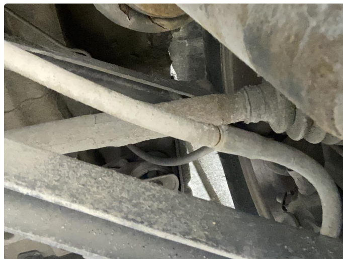
7.1 Defekt strømppe bremsewire bak, begge sider
