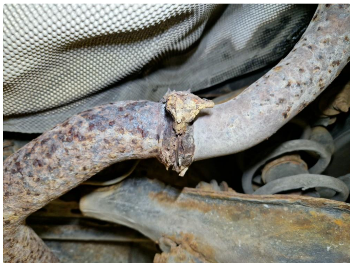
3.2 Rust eksosanlegg, spesielt i skjøter.
