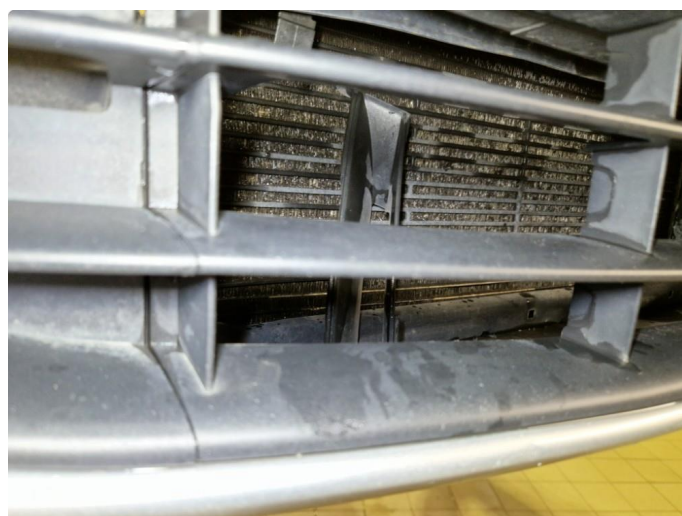
2.6 Skader / bruksmerker frontfanger.
