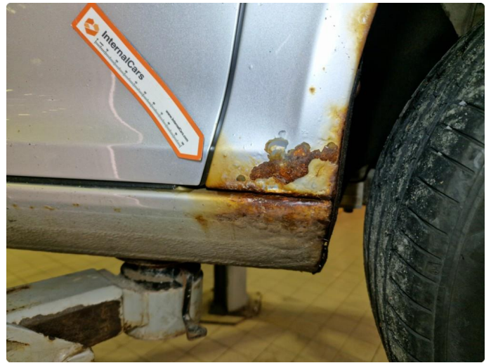
2.9 Rust fremre del kanal h+v side.
