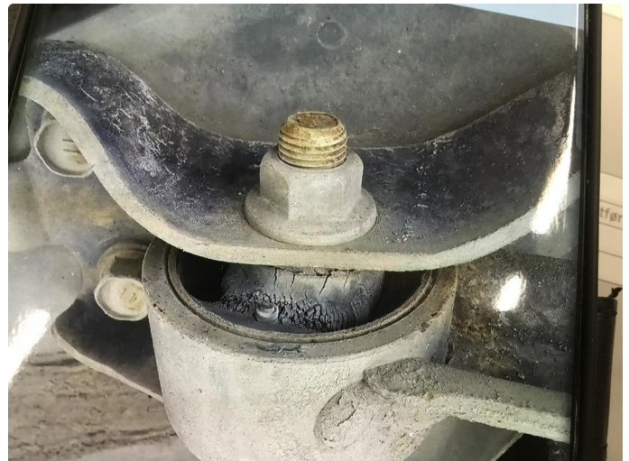
1.2 Sprikk i foringer bak. Foringer byttet nå
