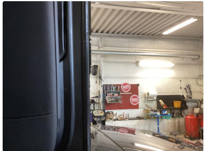
1.2 Pakning lett sprekker
