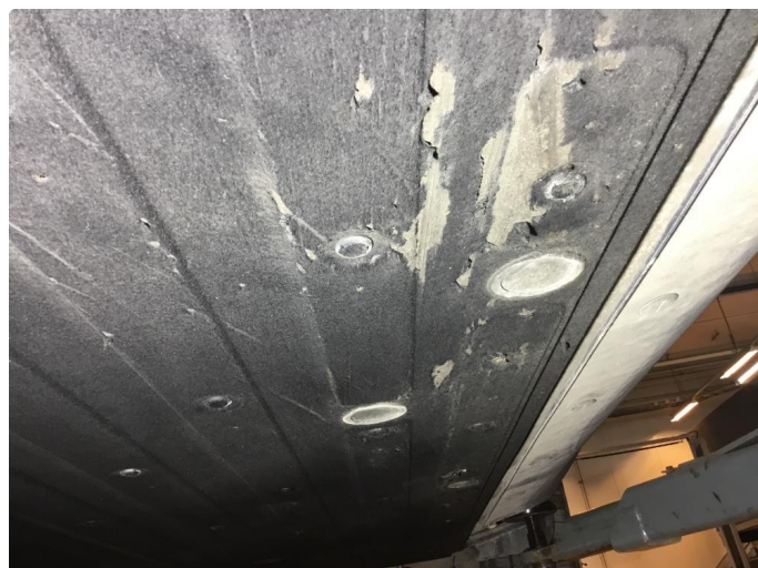
1.1 Beskyttelsesplate skadet/mangler
