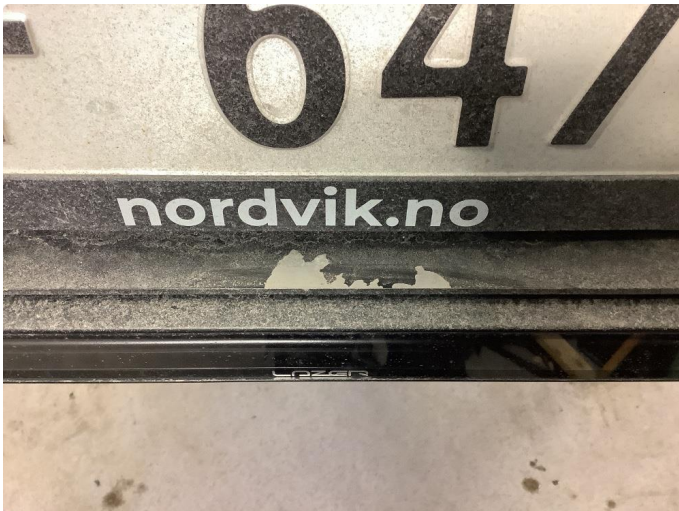
1.1 Lakk noe flasket av på brakett til LED-bar
