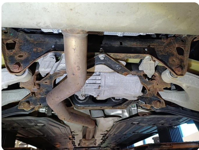
1.1 Rust Overflaterust hjuloppheng bak
