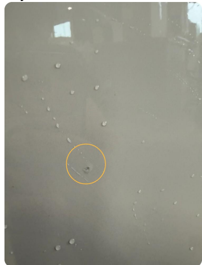
1.2 Steinsprut Normal slitasje - flekke
