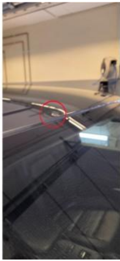
1.7 Liten bulk på taket
