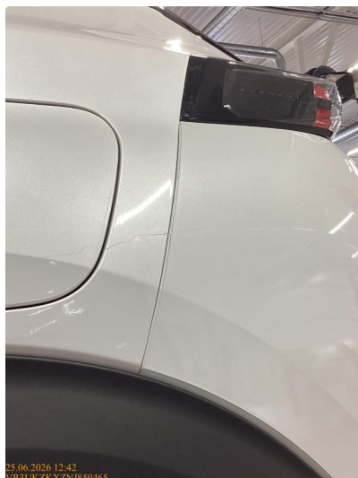
1.1 Ripe(r) ned til grunning
