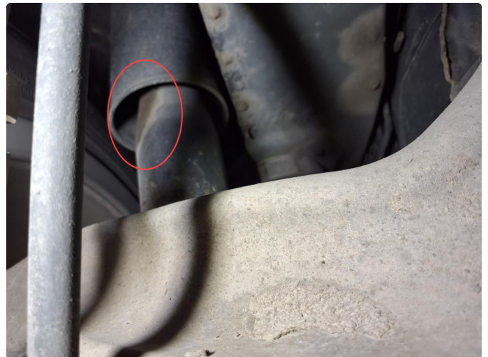
2.1 Noe lekkasje fra støtdemper venstre bak
