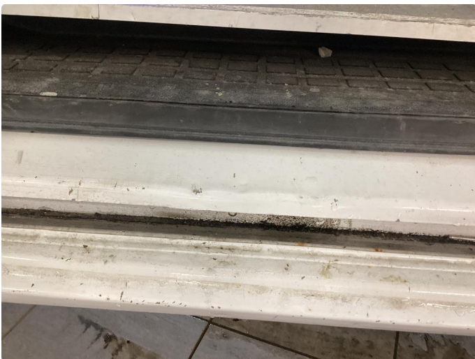
1.2 Bulk(er) med lakkskade
