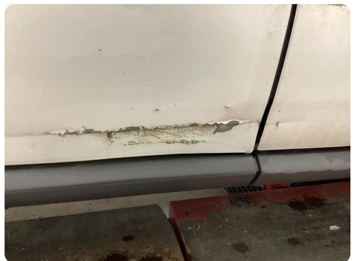
1.3 Skade Skyvedør hs har revnet.
