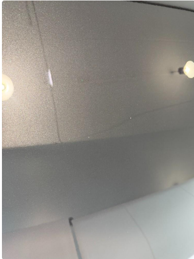
1.1 Noen få steinsprut på panser
