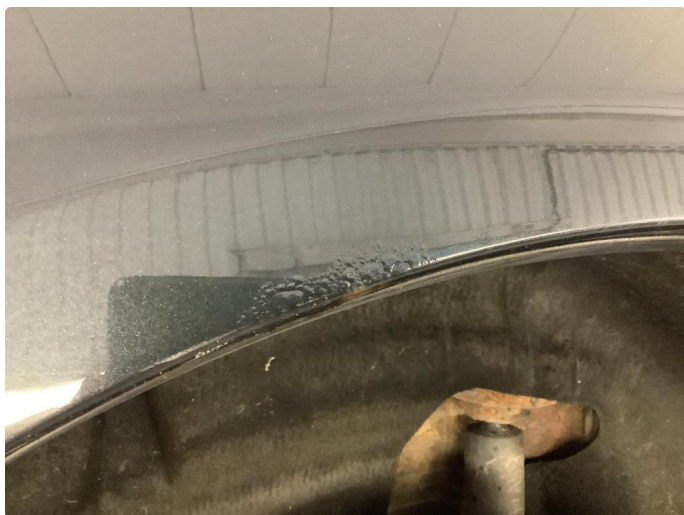
2.6 Generelt mye rust
