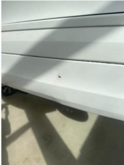
1.1 Liten lakkskade i fanger bak. Pusses og lakkeres forenklet
