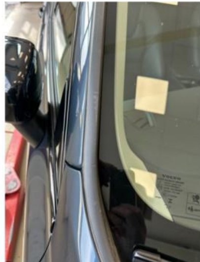
1.4 Noen riper i pakning ved frontrute høyre side
