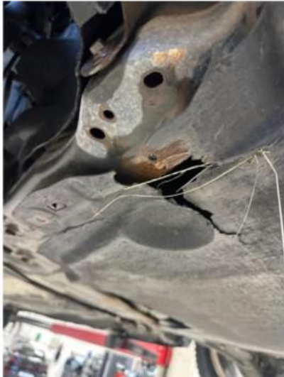
1.2 Noen sprekker i beskyttelsesplate under bil. Normal slitasje
