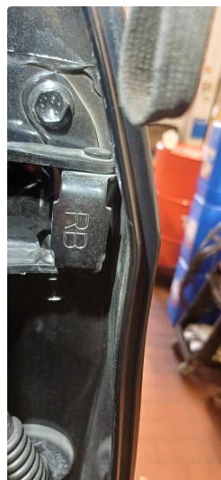
1.1 Ufagmessig utført arbeid
