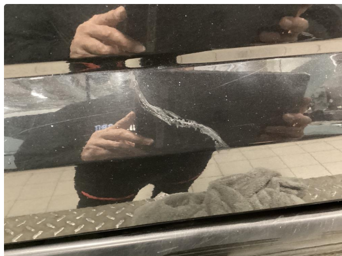
1.1 Ufagmessig utført arbeid
