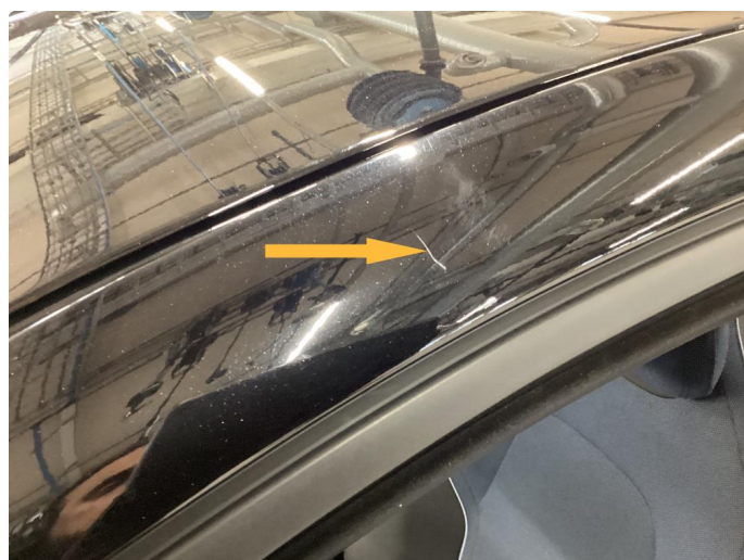
1.4 Ripe ned til grunning
