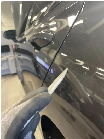
1.2 Bulk med lakkskade ( ordnes )
